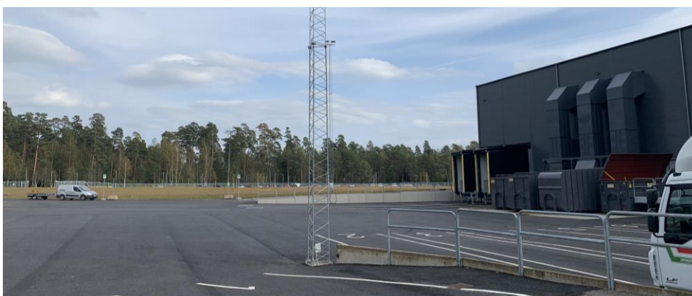
Delar av verksamhetens in- och utlastningsområde till höger i bild.
