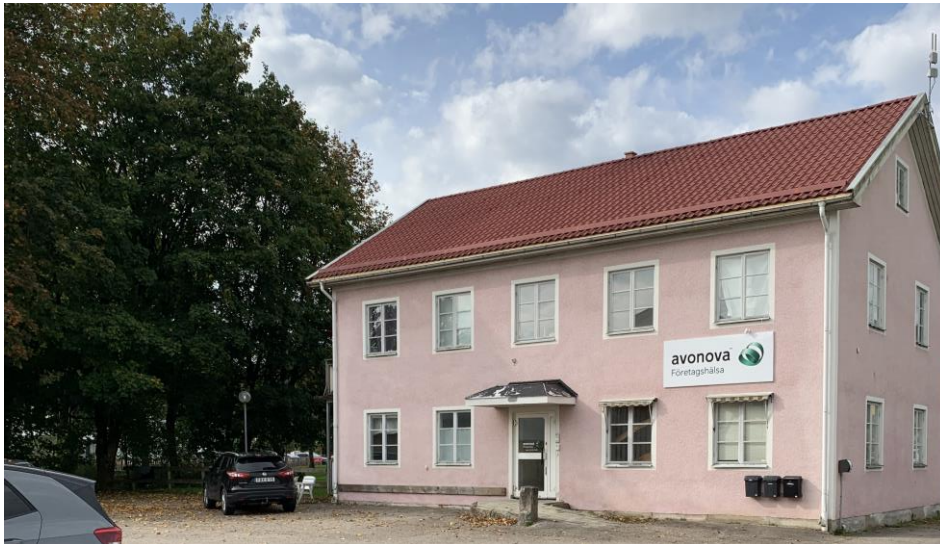
Figur 6: Den rosa byggnaden i planområdets västra del.
