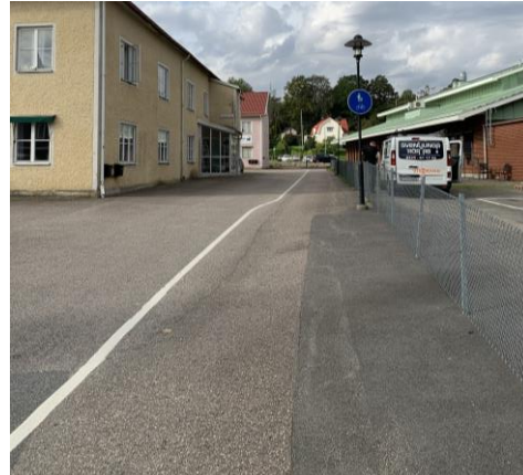
Figur 9: Befintlig gång- och cykelväg inom kvartersmark i planområdets norra del.
