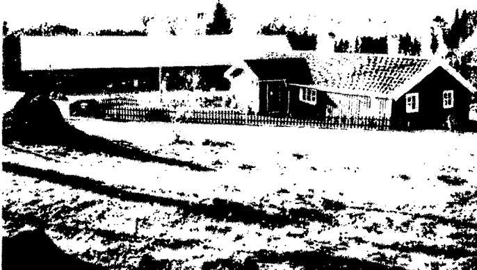
Bostadshus (1700-t/renov. 1984) , f.d. brygghus-uthus (1940-t), ladugård (1867), stenkällare (1800-t), garage (1950-t).
