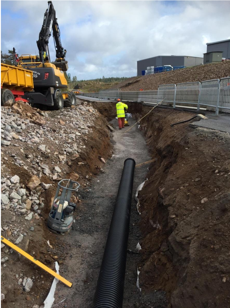
Bild 1: Ledningsarbete i Lockryd
