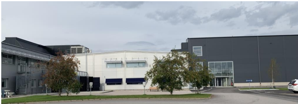
Delar av befintlig bebyggelse inom planområdet. Mörkgrå del till höger i bild, är den nyligen utförda tillbyggnaden.
