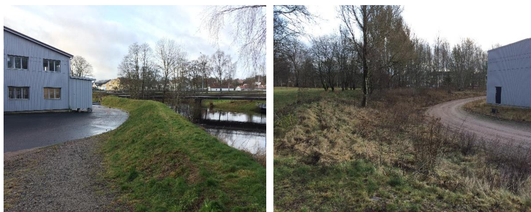
Figur 15 Anlagd jordvall för att skydda fastigheten Torstorp 2:1 (Blåkläder) vid högvattenföring i Åtran.
