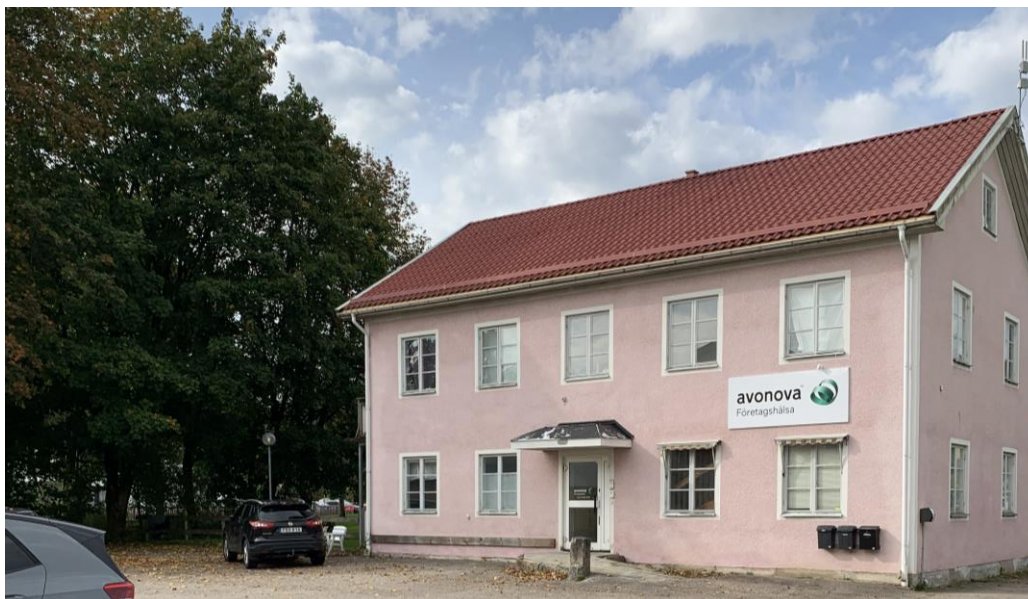
Befintlig byggnad i planområdets västra del.
