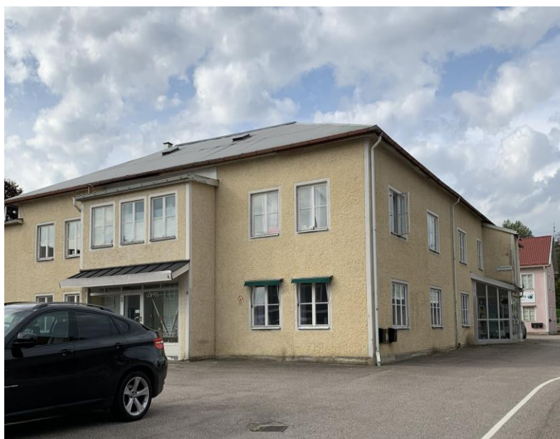
Befintlig byggnad i planområdets östra del, mot Kindsvägen.
