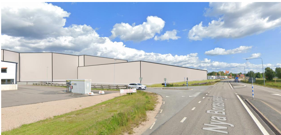
Gatuvy 2, från Nya Boråsvägen, sett norrifrån. Kartunderlag från Google Maps. Bsv arkitekter & ingenjörer ab, 2023.
