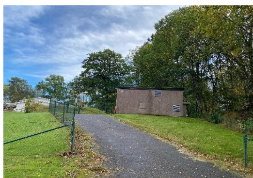
Figur 5. Foto på vattenverket. Figur 6. Foto på vattenverket från Klevsgatan.
